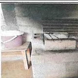
Sustitución de plancha de 3 hornillas en cocina.
