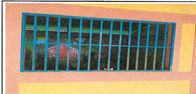
Mantenimiento a 4 balcones de la aula 2 y 3 (lijado y pintura)
