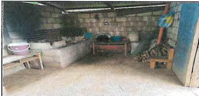
Sustitución de piso de cemento por piso cerámico antideslizante en cocina.
