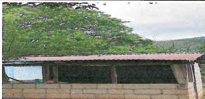
Sustitución de lamina acanalada por lamina troquelada en cocina (por mal estado)
