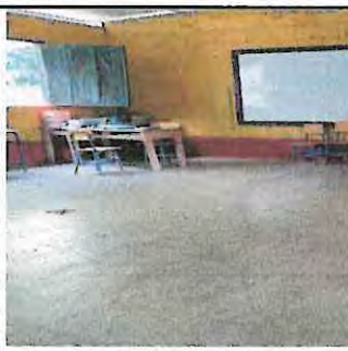
Sustitución de piso de cemento por piso cerámico en aula 1.
