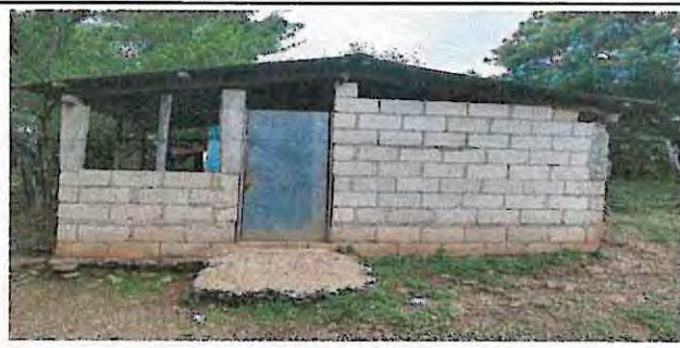
Sustitución de puerta de lamina por metal en cocina.
