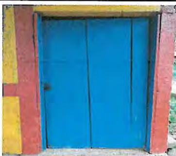
Sustitución de puerta de madera por metal en aula 1
