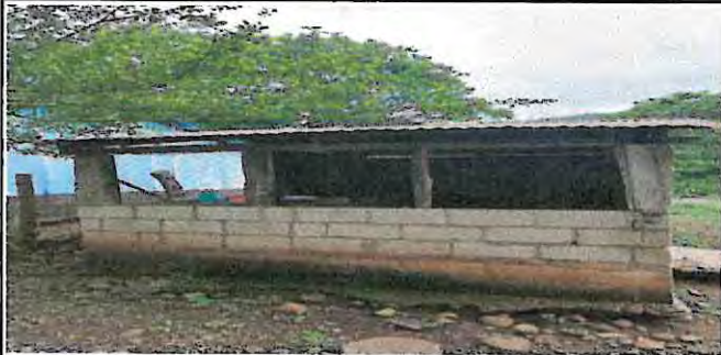
Implementación de depósito de agua en cocina.
