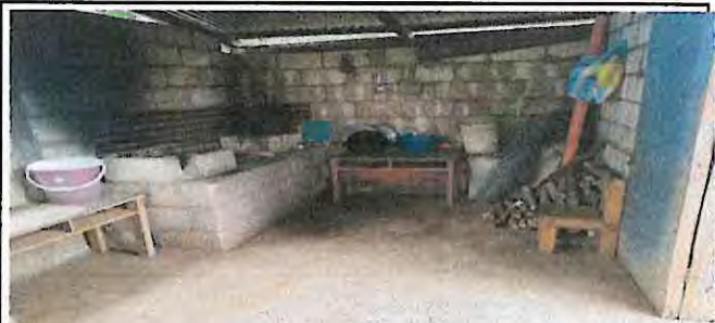
Implementación de chimenea con tubos de metal y campana.
