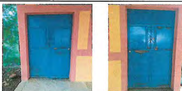
Mantenimiento total a 2 puertas de metal (lijado y pintura)
