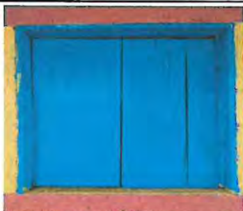
Sustitución de 5 ventanas de madera por ventanas de metal.
