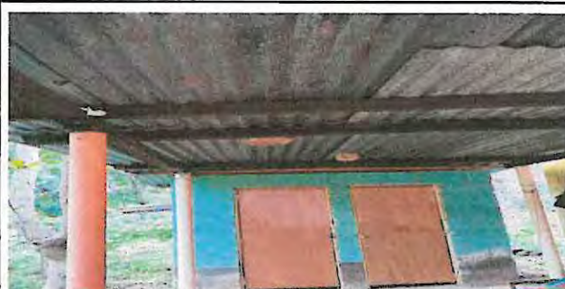
Sustitución de lamina acanalada por lamina troquelada en los sanitarios (por mal estado)
