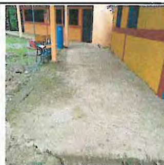
Reparación de piso torta de concreto en los corredores.
